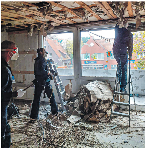
Die Sanierungsarbeiten fordern viel Einsatz von den Bürgern Foto: Allers
